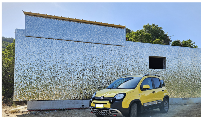
Vista del rivestimento in acciaio inox
